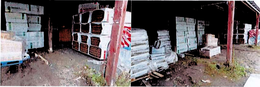
Skärmtak, runt fastigheten
