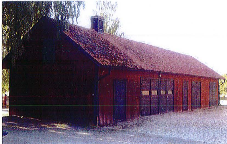
Den västra uthusbyggnaden, utmed Museigatan, är uppförd med stående träpanel och sadeltak.
