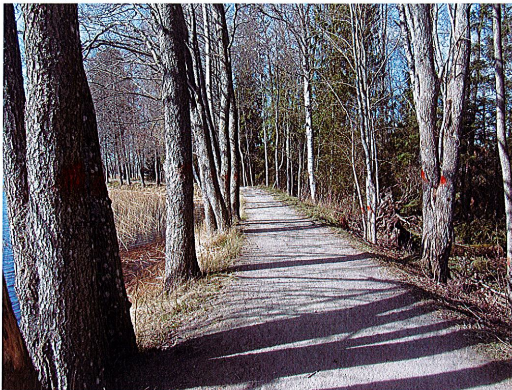
Figur 5 Alla träden på bilden måste betraktas som utgörande en risk för dammsäkerheten
