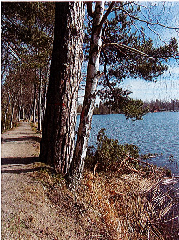
Figur 4 Smalt dammkrön – en rotvälda från ett omkullvält träd skulle leda till att en stor del av dammkrönet försvann. I kombination med hög vattenyta i magasinet innebär det en omedelbar risk för dammbrott.
