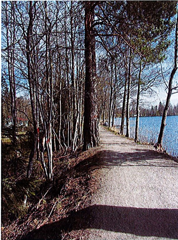
Figur 7 Stor tall i nedströmsdelen av dammkrönet. Även de mindre björkarna i nedströmsslänten kan ha rötter som letar sig genom dammvallen till vattnet i magasinet.
