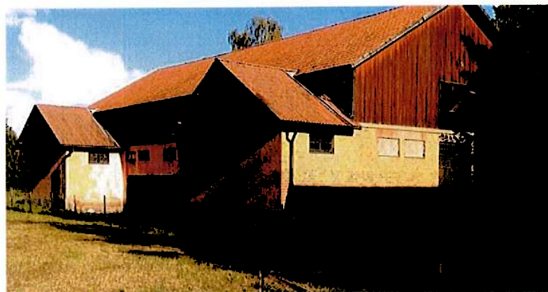
Bild 11. Den östra byggnaden är uppförd i lertegel och stående träpanel på den övre delen av fasaden.
