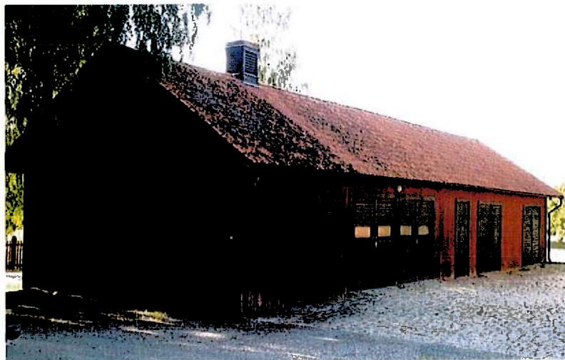
Bild 10. Den västra uthusbyggnaden, utmed Museigatan, är uppförd med stående träpanel och sadeltak.
