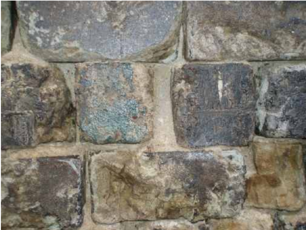
Figur 15 Slaggblock som gjutits i rektangulär/kvadratisk form för användning som byggnadssten.
