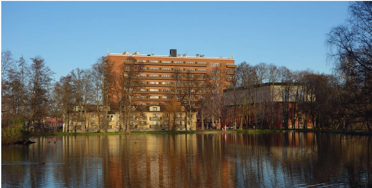
Vy från stadsparken med en möjlig utformning enligt detaljplanen. Lasarettetsbyggnadens södersida samt påbyggnad på lågdelen. Illustration: Lindh Arkitektur.
