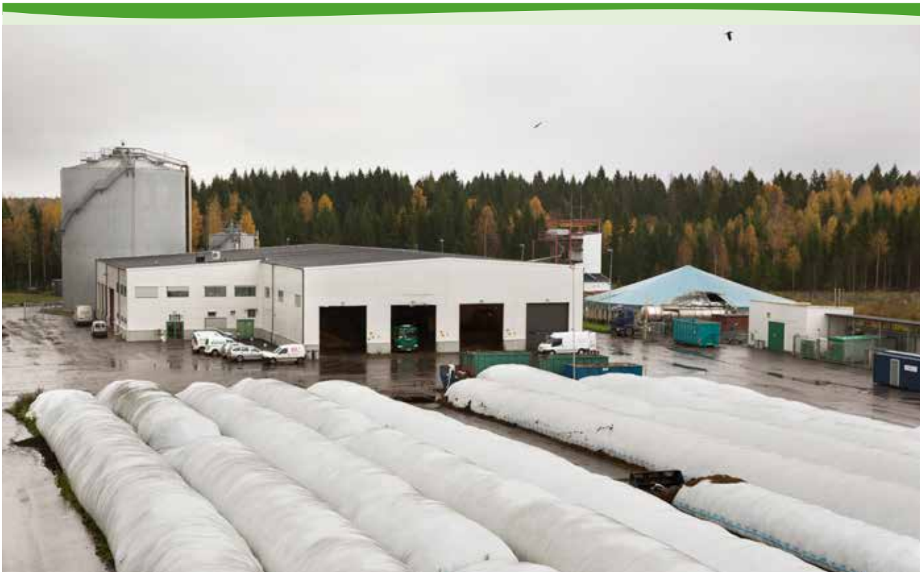
Biogasanläggningen på Gryta i Västerås byggs ut. Den förväntas vara klar i juli 2020 och kan då ta emot 40 000 ton biologiskt avfall per år för produktion av biogas och biogödsel.
