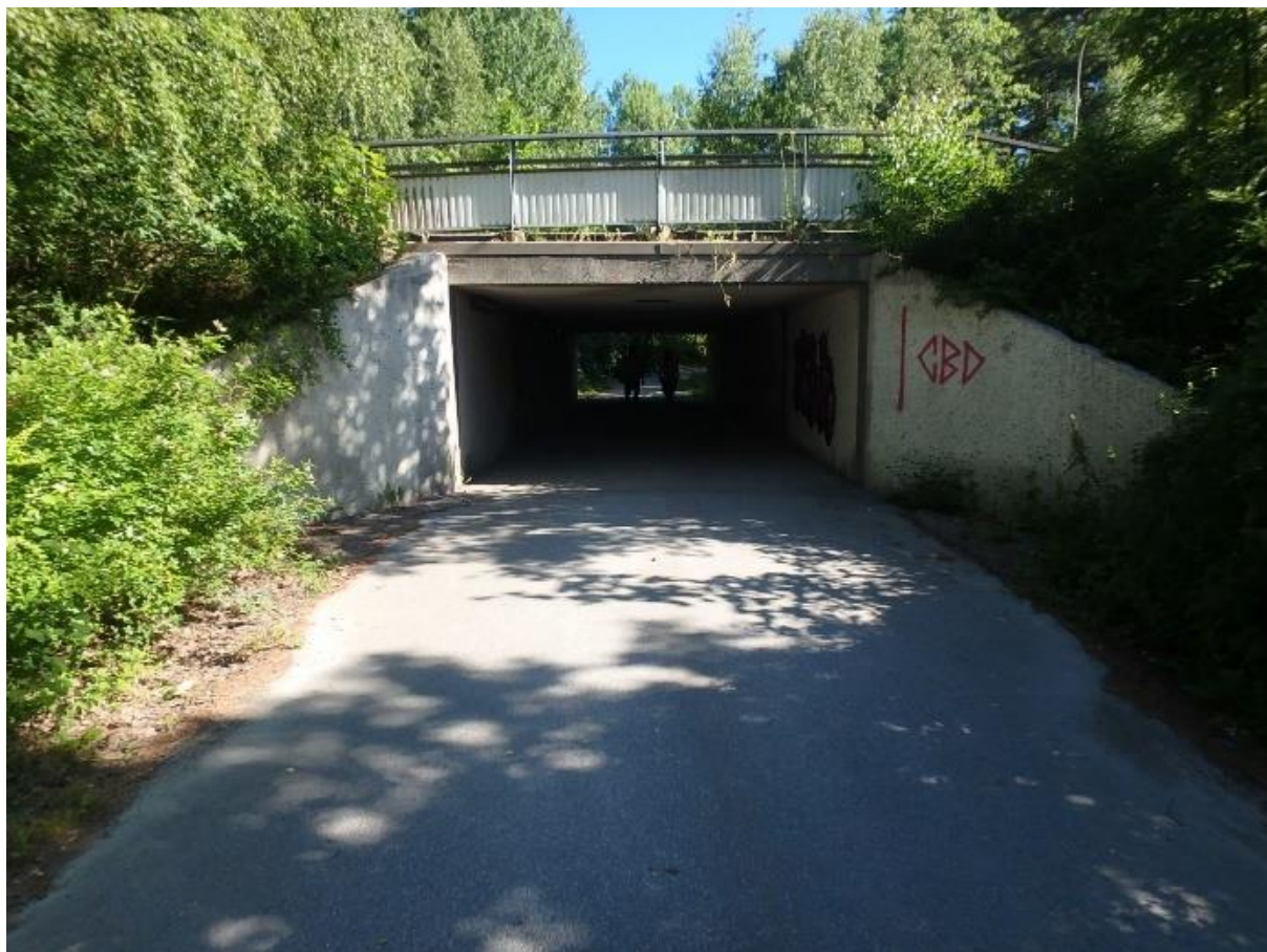
Figur 11. Gång- och cykeltunnel under Norrleden, kopplar mot Kulbanegatan och Wijkmansgatan (Trafikverket, 2022).
