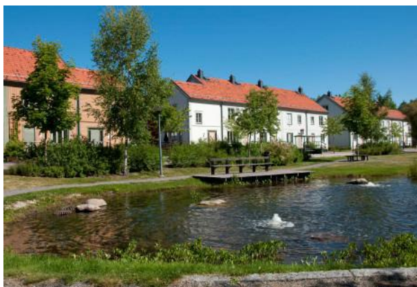
Exempel på dagvattendamm i Tullinge Träd-gårdsstad. Foto: Tullinge kommun, 2010.
