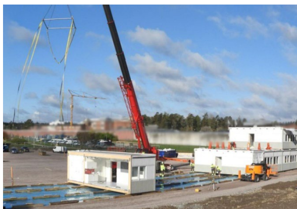
Figur 18: Gärdesta modulskola monteras på slipers maj 2022 (bild: Fastighetsenheten Sala kn).
