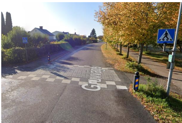
Figur 34 Hastighetssäkrad passage Gruvvägen, Sala
