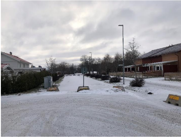
Figur 23 Betongsuggor på Galaxgatan sett åt söder.
