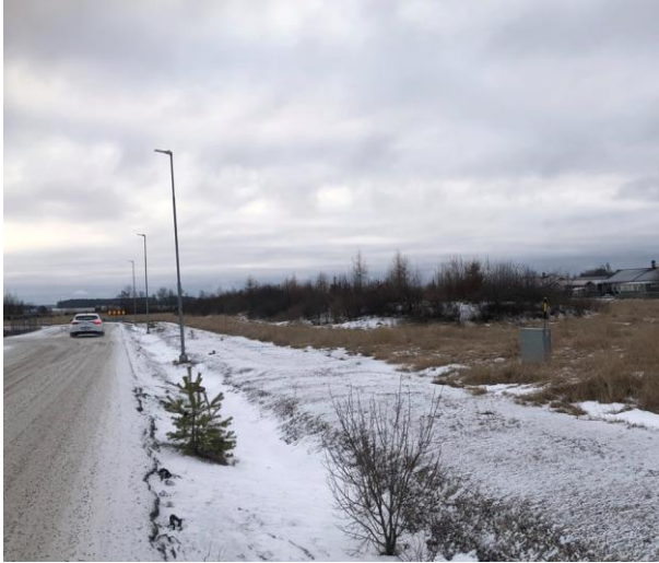
Figur 6 Yta förberedd för GC-väg
