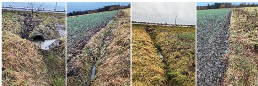
Bilder från det östvästliga diket mellan norra och södra delen av verksamhetsområdet.
