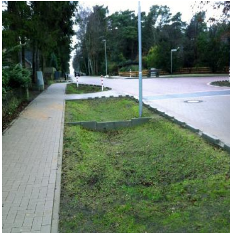
Figur 21. Exempel på svackdike med dämme i gatumiljö. Foto WRS, källa Stockholm Vatten och Avfall.
