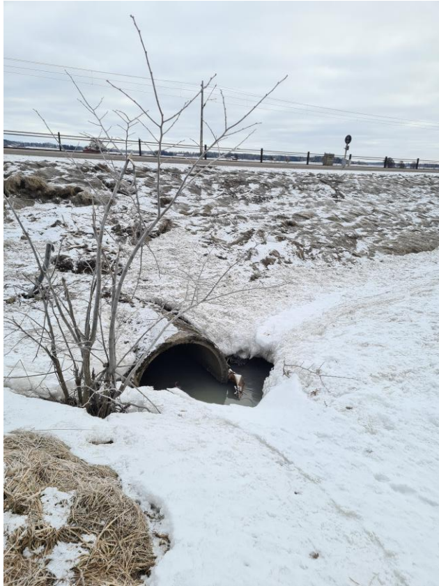
Figur 9. Trumman under riksväg 56.
