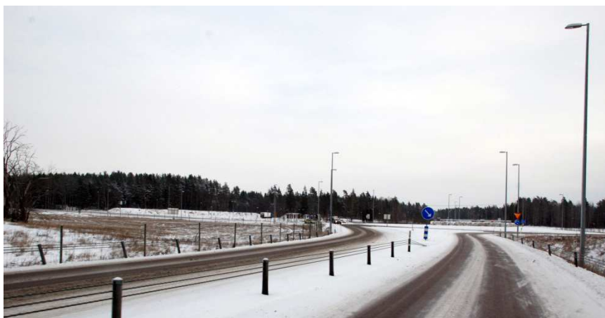
Cirkulationsplatsen, sedd från väster/Mora, med rastplatsen i fonden.
