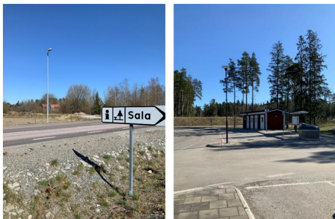
Figur 4 Foton från rastplats Evelund, infarten vid väg 800 Västeråsleden samt servicebyggnaden inne på rastplatsen. (Foto: WSP)
