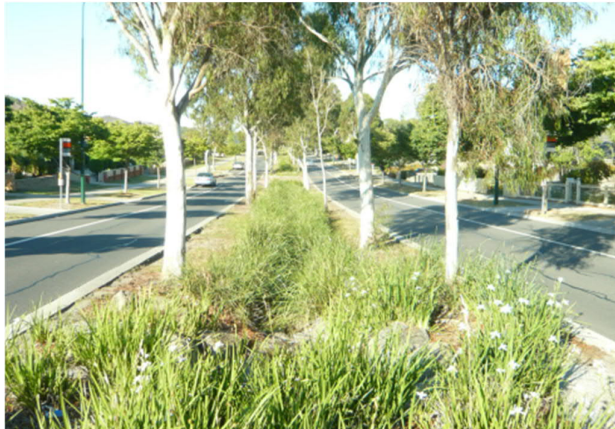
Figur 25. Exempel på trädplantering i skelettjord för omhändertagande av vägdagvatten. Trädplanterings mitt har även en funktion av svackdike vid höga flöden.
