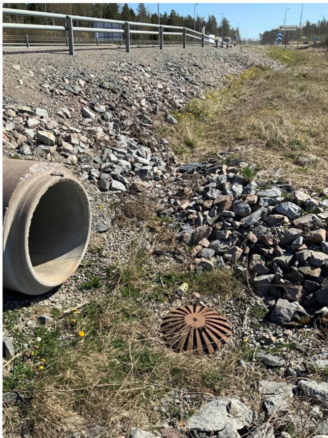
Figur 10. Trumma under väg 56/70, utlopp på södra sidan av vägen, samt kupolbrunn.
