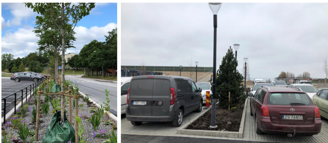
Figur 23. Exempel på LOD-lösning i för parkeringsyta. Principen går ut på att dagvatten kan fördröjas i bärlager som på ett eller annat sätt underlagrar yta (översta bilden samt nedre högra). Nedre bilden t.v. är ett exempel på ett vegetationsklätt stråk.
