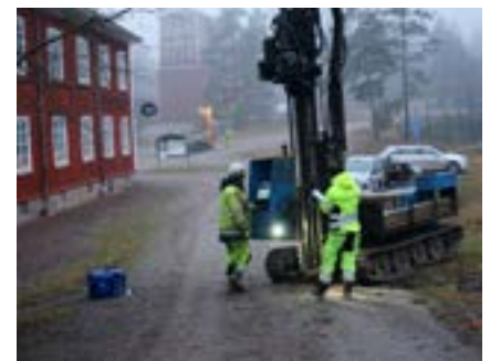
I mitten av december genomfördes provtagningar för att utreda existerande miljöföroreningar samt geotekniska förhållanden. Foto: Ulrika Larson, Empirikon Kommunikation
