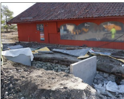
För att kunna bevara en del av rälsbanan från 1816 sätts L-stöd på varsin sida av den delen som vi inte återfyller med massor. Foto: Ulrika Larson
