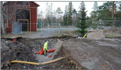
Schakt för dagvatten utanför Pumpborrningshuset, centrala gruvområdet vid Sala Silvergruva. Foto: Ulrika Larson
