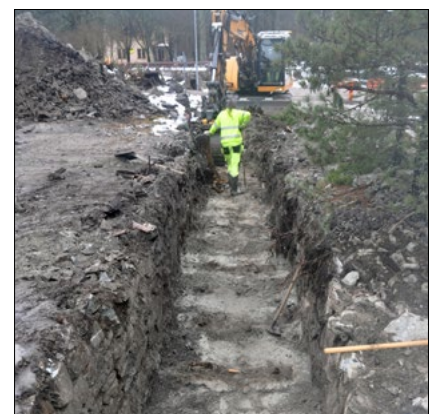
Ytterligare en rälsbana som går mellan Skrädhuset och Gruvstallet har grävts fram. Foto: Leif Berggren, Berggren byggnadsvård
