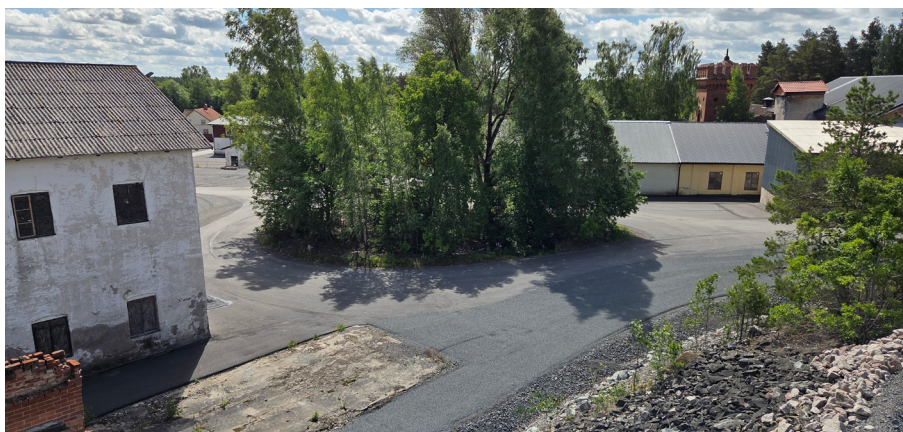
Området Sala Bly och hyttan, krossplan och hjulhuset är nu åtgärdat med asfalts- eller grustäckning. Alla områden där det har funnits risk för exponering av metaller via damning är åtgärdade. Det som kvarstår vid Silvergruvan är varphögarna och Afterskansen. Foto: Carl Svedjelid
