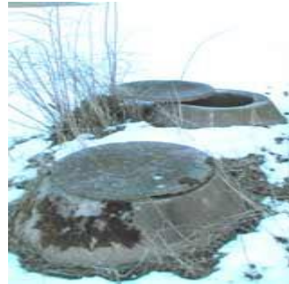
Bilder: Slamavskiljare i betong (www.avloppsguiden.se)
