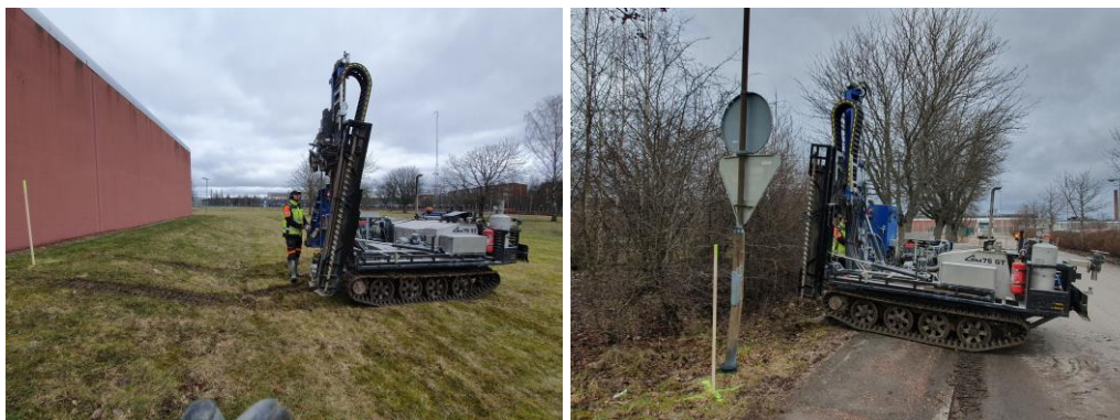
Bild 3.1.1 och 3.1.2: Bilderna visar sondering i borrhypunkt 6 (vänster bild) just utanför och öster om muren och sondering i punkt 15 på den västra sidan av Cirkelgatan. Sondering kunde inte utföras längre österut mot anslutningspunkten på grund av markförlagda ledningar i osäkert läge.
