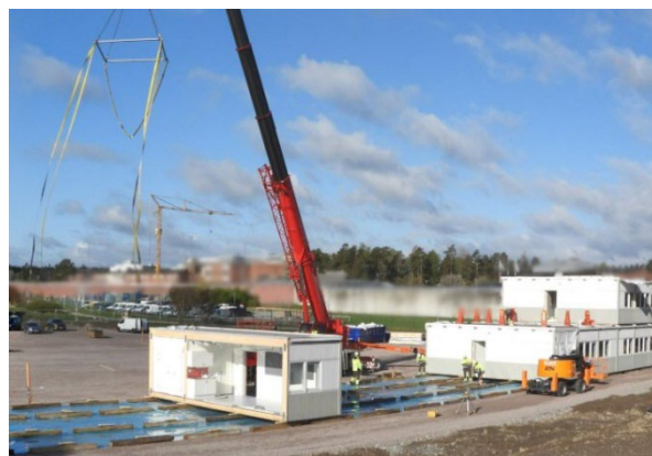
Figur 18: Gärdesta modulschoola monteras på slipers maj 2022 (bild: Fastighetsenheten Sala kn).
