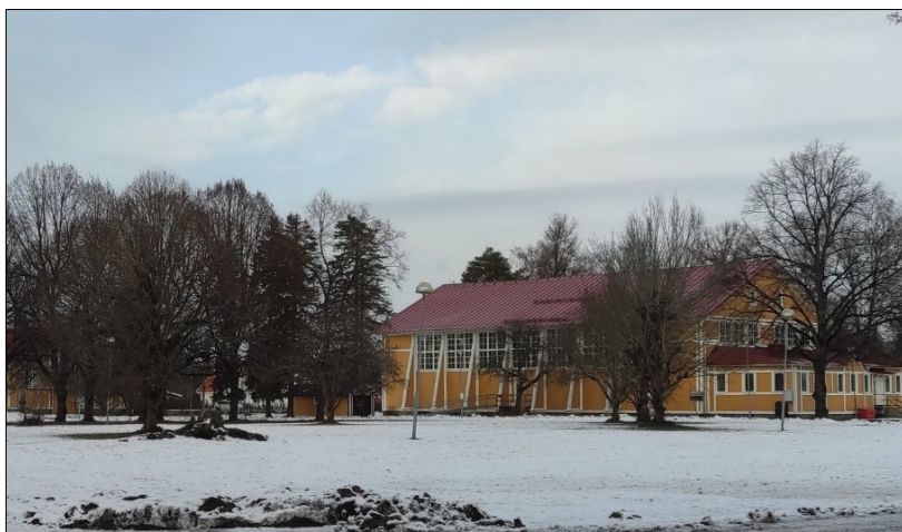
Figur 14: Kulturhistoriskt viktiga byggnader, exercishuset samt skymd till vänster ridhuset. I förgrunden platsen för själva kasernbyggnaden som 1930 omvandlades till sjukhus (byggnaden revs 1983). Se även figur 16 nedan.
