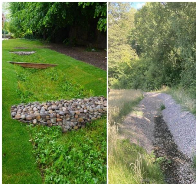
Figur 22. T.v. ett svackdike med dämmen. Dämmen ökar utjämningskapaciteten i ett svackdike. Svackdiket kan leda dagvatten till en annan dagvattenåtgärd, som svackdiket till höger som leder det till en dagvattendamm. Foto: t.v. Jonatan Malmberg, t.h. Anna Pettersson Skog
